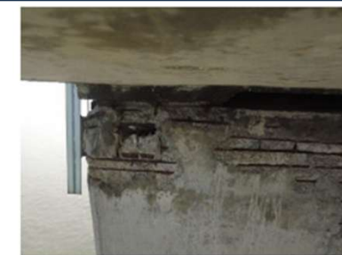
Figure 8 : vue d'une zone de cachetage - Pile P13
