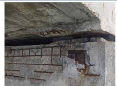
Figure 9 : vue d'une zone de cachetage - Pile P17
