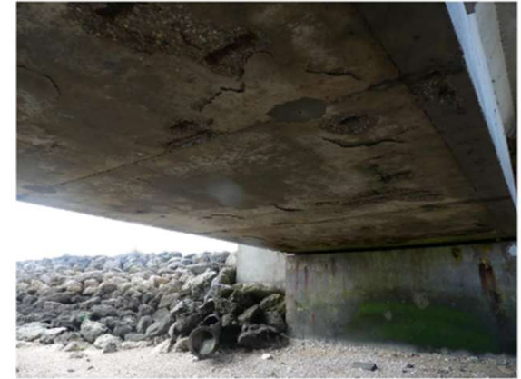
Photo 72 : Aciers apparents corrodés, éclats de béton et amorces d'éclat en hourdis inférieur du voussoir 46.C2
