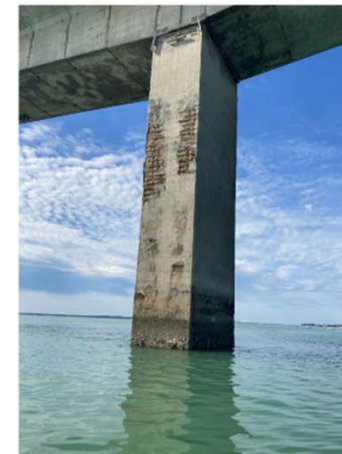
94 : Fissure horizontale, coulures d'oxyde et aciers apparents corrodés sur P3, face Sud
