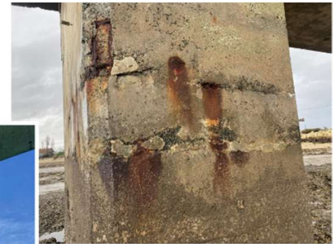
94 : Fissure horizontale, coulures d'oxyde et aciers apparents corrodés sur P3, face Sud
