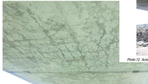
Photo 44 : Faïençage en hourdis inférieur du voussoir 23A2
